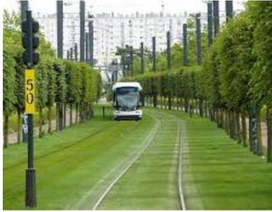
**L'engazonnement des voies de tramway** contribue de manière très visible à la végétalisation de la ville. Au-delà du gain esthétique, ce verdissement réduit un peu les nuisances sonores du tram et participe à limiter le ruissellement des eaux pluviales.
