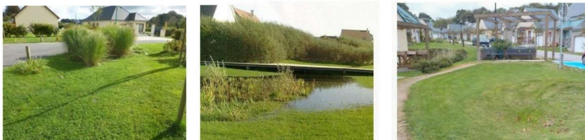
Figure 8-1 : exemple d'ouvrage d'infiltration des eaux pluviales (jardins creux, espaces inondables)
